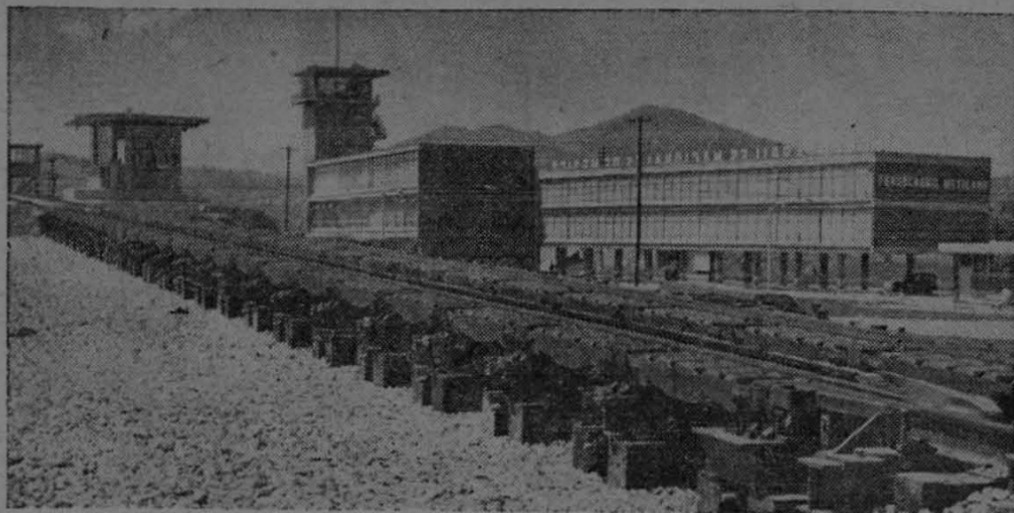
Oficinas centrales de la nueva terminal ferrocarrilera del Valle de México, considerada como una de las más modernas entre las existentes hoy en día en el mundo. En primer término, el retardador principal de velocidades que permite realizar movimientos exactos y controlados de vagones en la nueva terminal.
